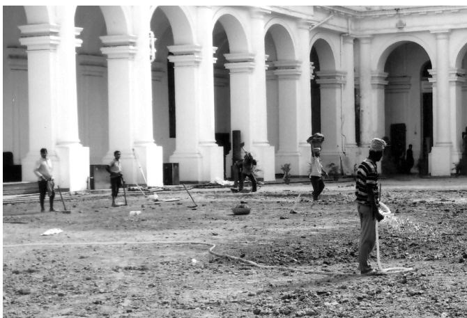
インド博物館中庭の改修工事。すべて手作業だ
